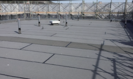
アスファルト防水(熱工法)
