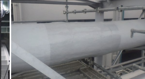
FRP製配管補修
