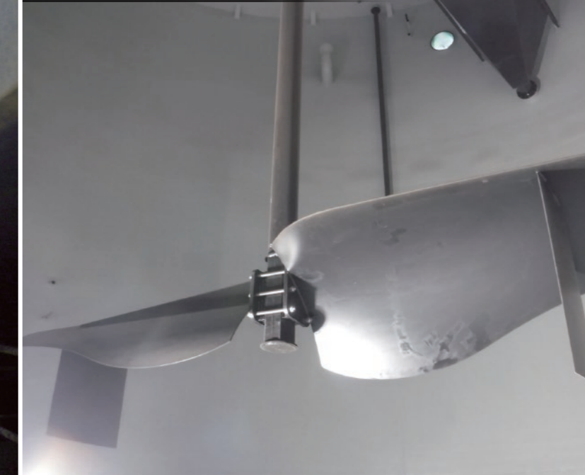
ビニルエステルフレーク防食(シュクラFA-1D工法) 富士市東部浄化センター・消化槽
