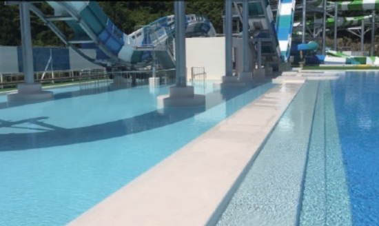
FRP塗膜防水(プール工法)
