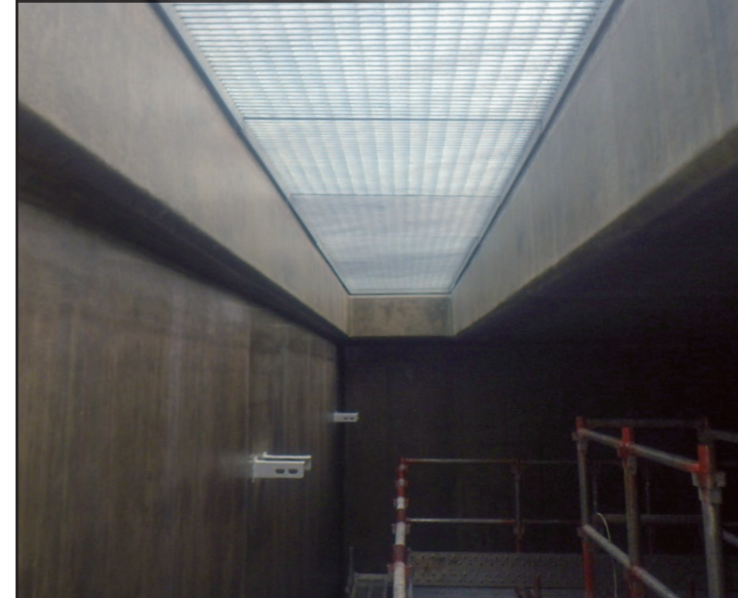
FRP防食(シュクラV-2工法、他) 武豊火力発電所・廃液槽
