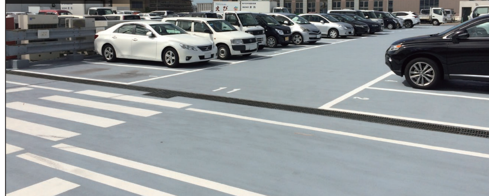
ウレタン・FRP複合塗膜防水 神戸市中央卸売市場・屋上駐車場
