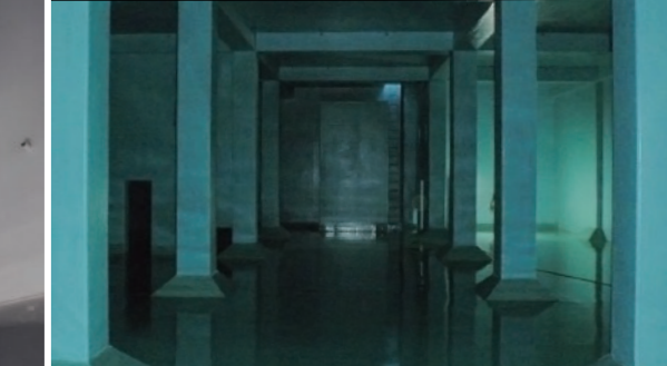
上水向けFRP防食(ピュアラPUR-1工法)
