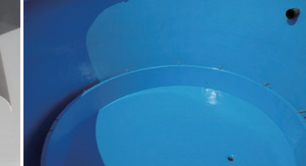
上水向けエポキシ防食(ピュアラPE-1工法)
