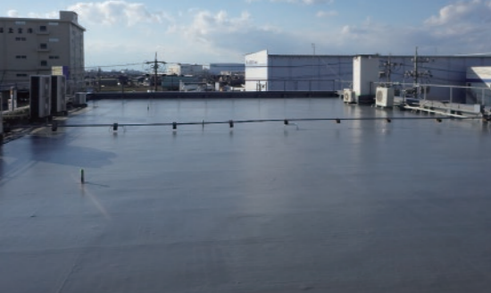
シート・FRP複合防水
