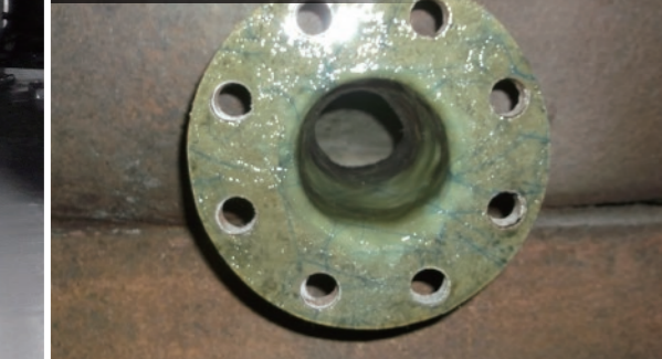
FRP製フランジ補修
